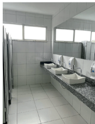
BANHEIRO FEMININO E MASCULINO
